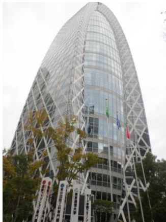
写真 1：国際ファッション専門職大学の外観
